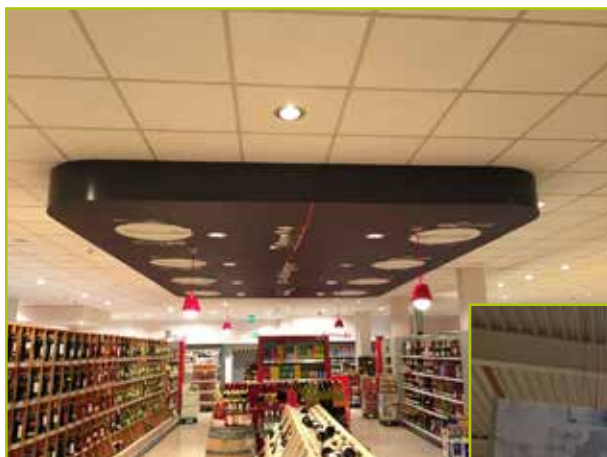
Akoestisch plafondelement inclusief LED-verlichting
